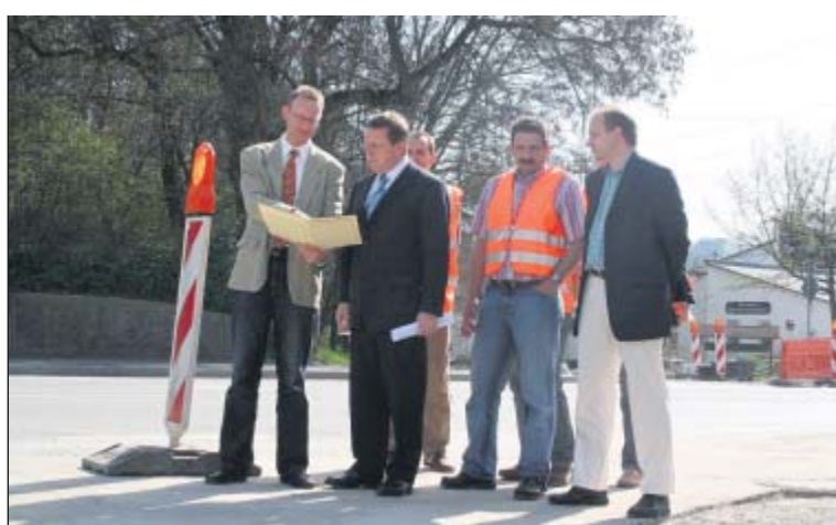
Oberbürgermeister Henry Schramm lässt sich von den Fachleuten vor Ort die Sanierungsmaßnahmen an der Saalfelder Straße erläutern. Foto: Ihl
