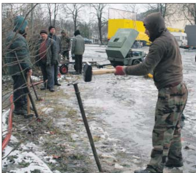
Die Aufbauhelfer wechseln sich beim Einschlagen der Erdnägel ab.
